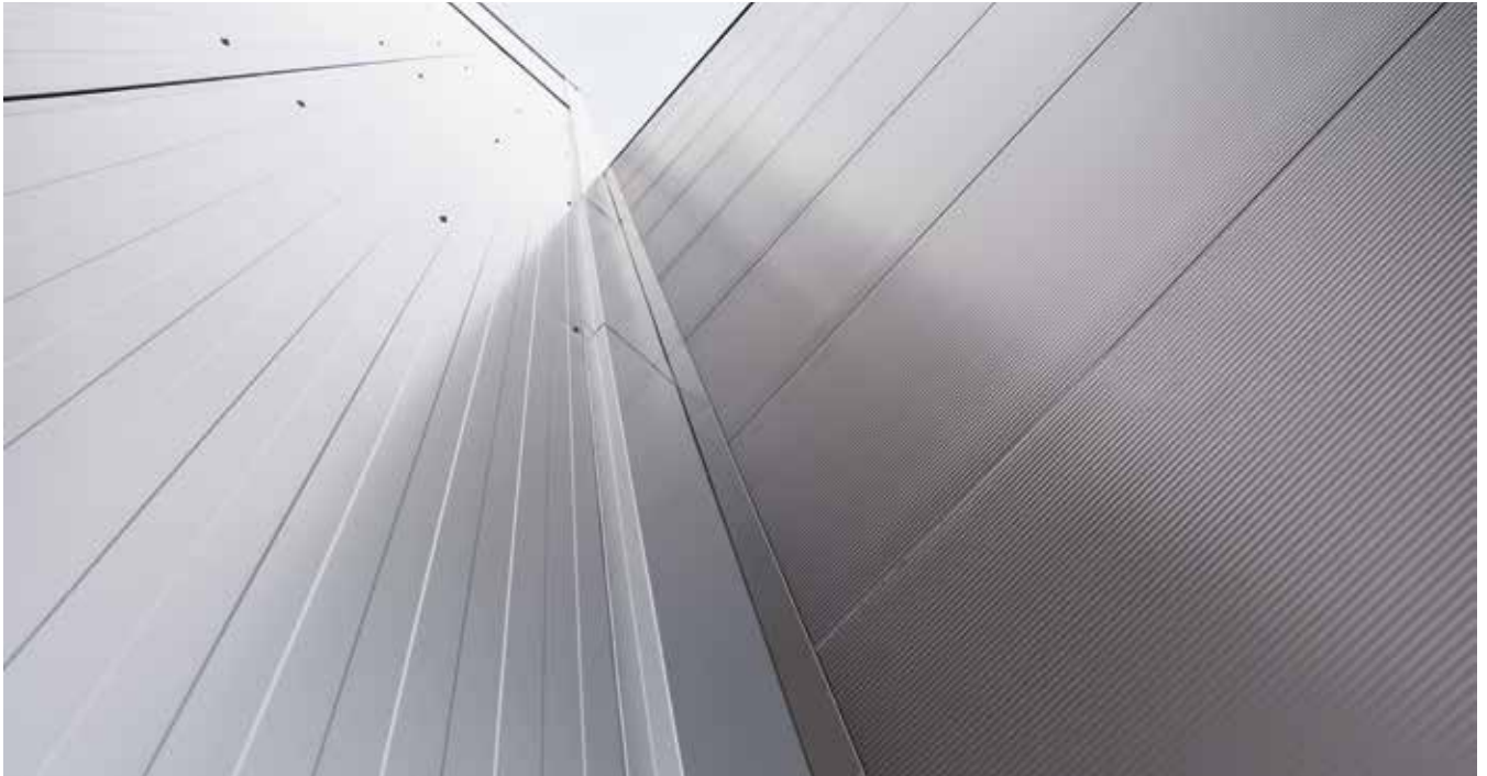
30 m hohes Tiefkühlhochregallager
